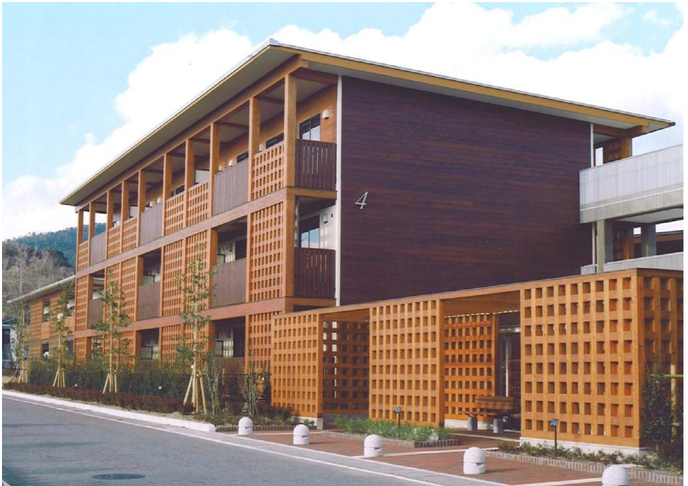
写真 完成した木造の県営住宅
