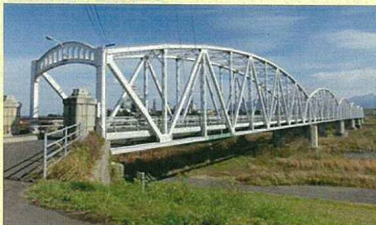
旧日野橋(曲弦式6連ワーレントラス橋)
