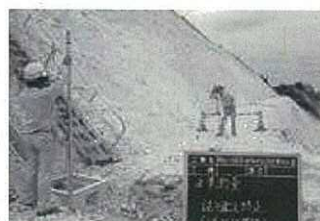
2次製品設置後の水準測量中
