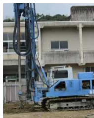
地盤改良工事
