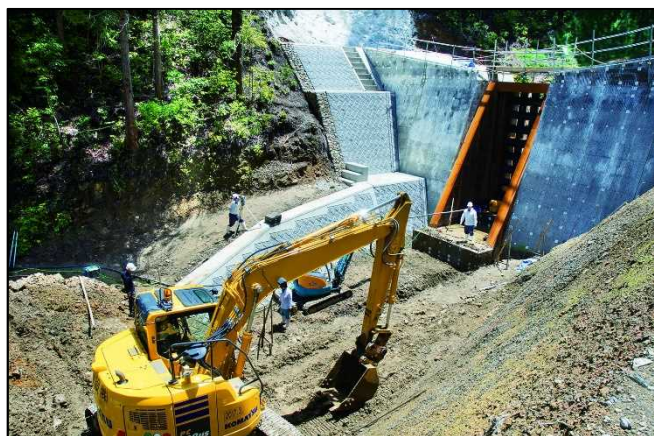
砂防ダム工事現場
