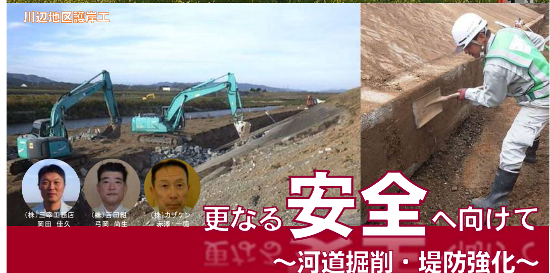
小田川河道掘削
