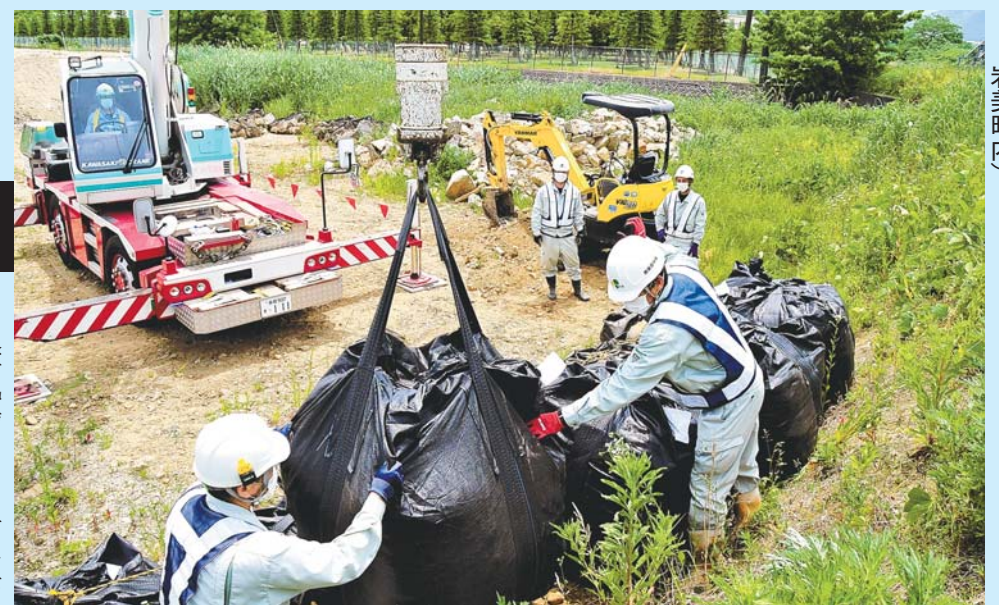
クレーン車で土のうを積み重ねる(6月5日、岩美町内)
