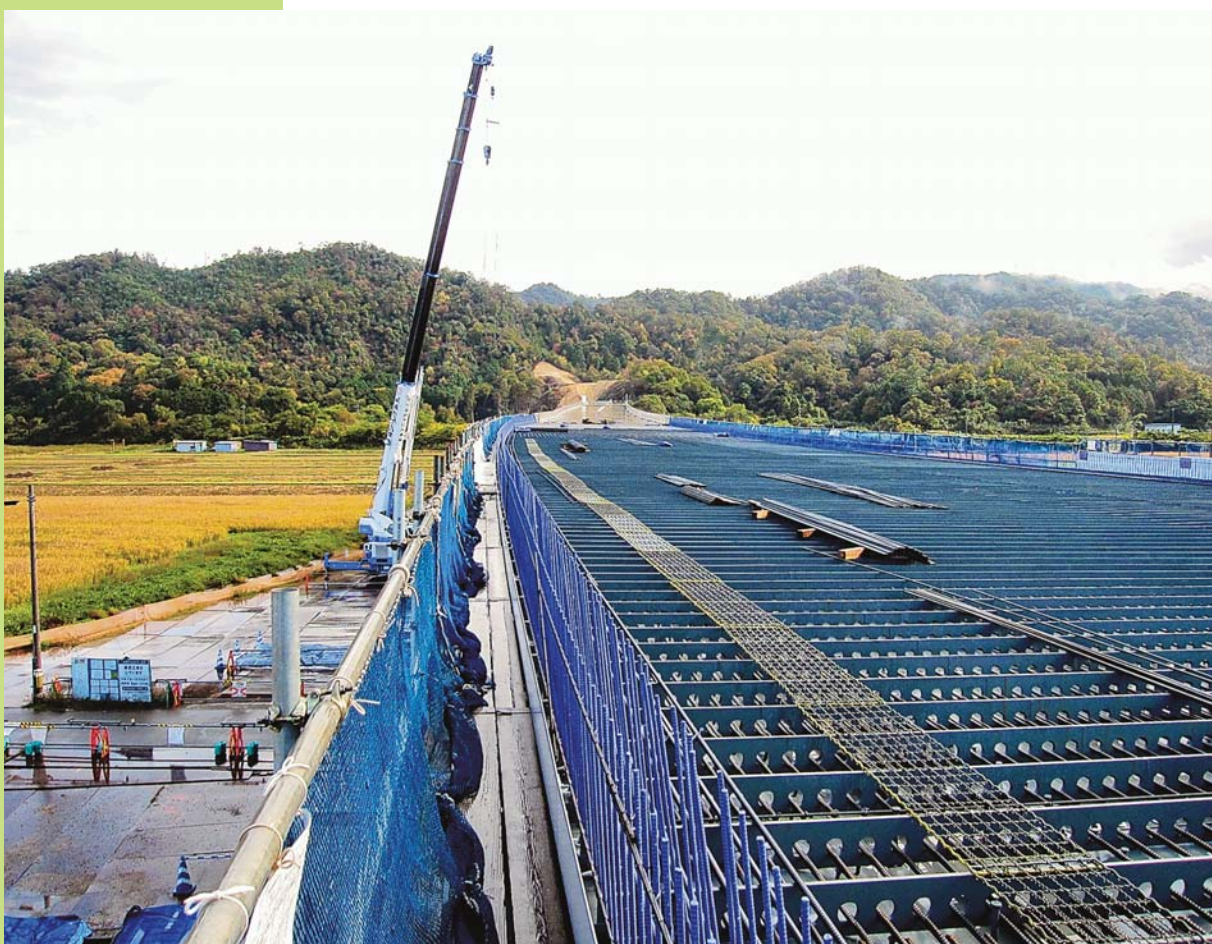
国道178号「若美道路」浦富高架橋の上部工事 (若美町、2020年11月)
