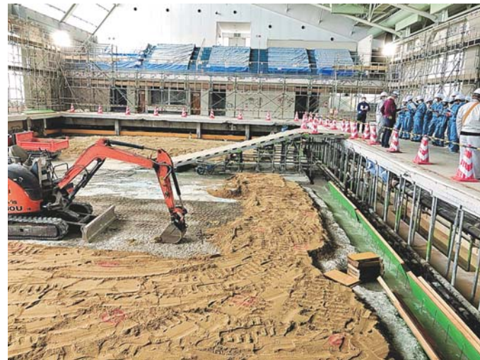
鳥取県内ブルー25ビル改修外工事 (鳥取市、2020年11月)
