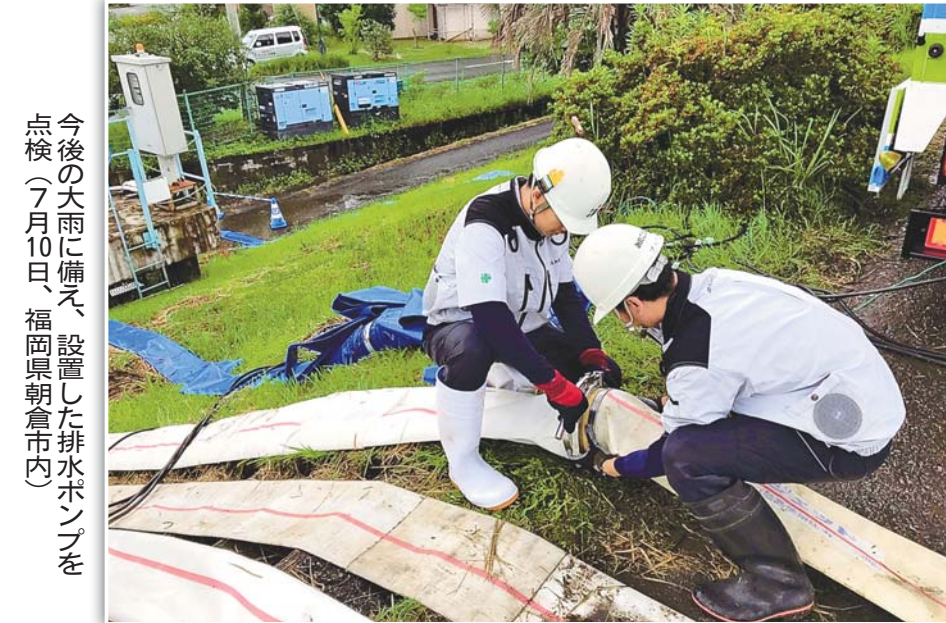
熊本県に派遣された鳥取河川国道事務所のT.E.C.F.O.R.C.E隊員が道路崩壊現場で被害状況を調査(7月12日、熊本県八代市内) = 同事務所提供
