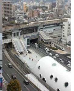
↑ 白島新駅(広島県広島市)
