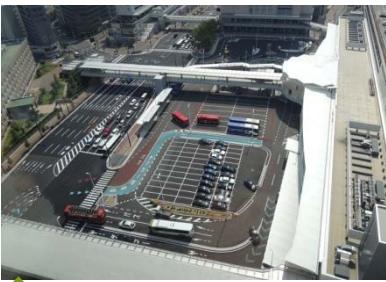
↑ 北口広場再編、自由通路 ペDESTリアンデッキ(広島県広島市)
