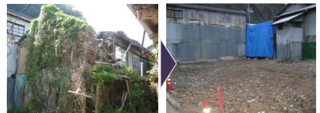
↑ 倒壊の危険のある建物を除却（広島県大崎上島町）
