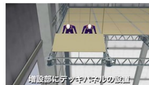
増設部にデッキパネルの取付
