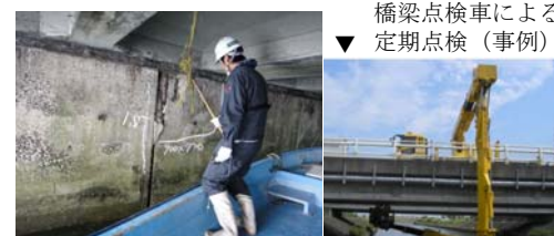
▲栈橋下面部の定期点検（事例）
