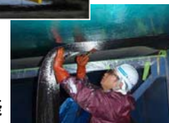
▲炭素繊維シートによる床板ひび割れ対策（事例）
