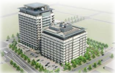
防災拠点となる官庁施設の整備
