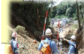
TEC-FORCE(緊急災害対策派遣隊、国土交通省)による緊急災害対策派遣
