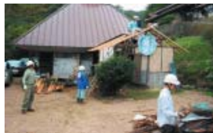
空き家改修ワークショップ
