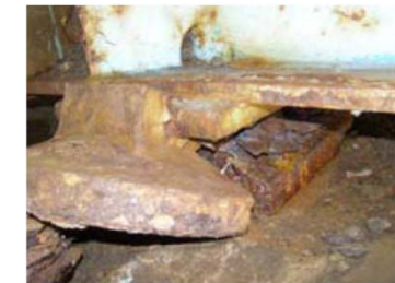
鋼製支承の損傷 (国道29号 須澄橋)
