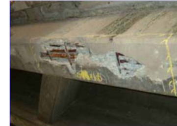
経年劣化及び中性化による主桁コンクリートの剥離及び鉄筋露出 (国道2号 山王橋)
