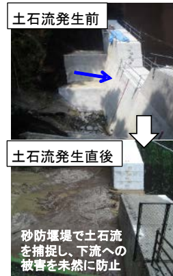
▲砂防堰堤の効果事例 豪雨災害復興まちづくりビジョン」(広島市安佐南区大町地区)
