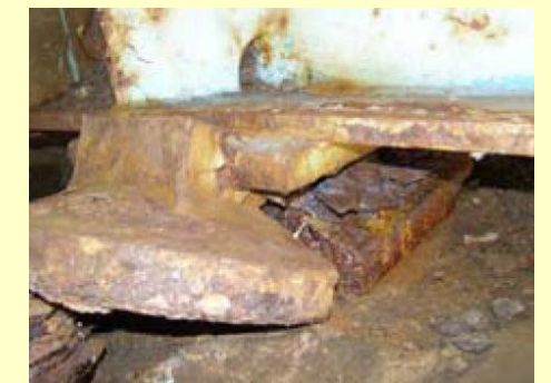
鋼製支承の損傷 （国道29号 須澄橋）
