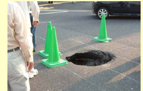
老朽化した下水管渠腐食に起因する道路陥没状況（広島市中区舟入南） 出典：広島市
