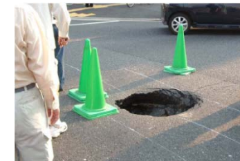
老朽化した下水道管渠腐食に起因する道路陥没状況 (広島市中区舟入南) 出典：広島市
