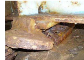
鋼製支承の損傷 (国道29号 須澄橋)
