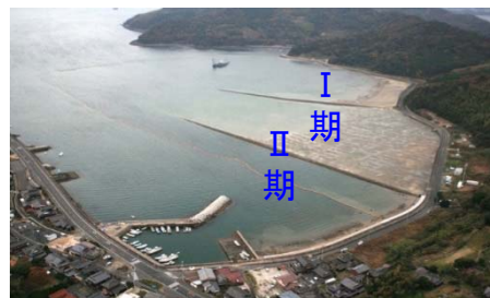
徳山下松港 大島地区人工干潟(山口県周南市)
