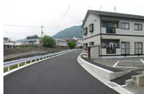
【地域と協力して整備した道路】
