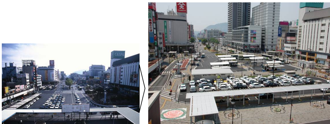
写真（左：整備前、右：整備後）
