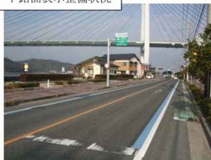
写真2 因島（田熊町 生口橋）
