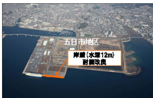
【写真1 広島港五日市地区耐震強化岸壁】
