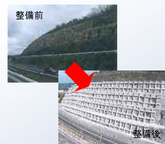
▲道路斜面の防災対策
