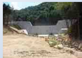
▲砂防堰堤整備
