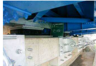
▲落橋防止装置の設置
