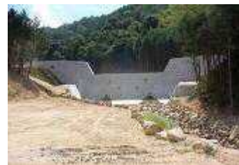
▲砂防堰堤整備
