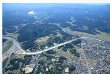
▲斐伊川放水路
