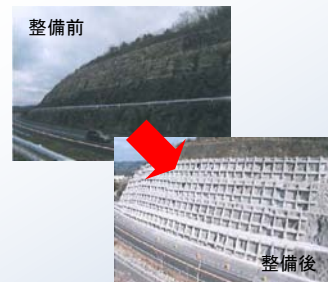
▲道路斜面の防災対策
