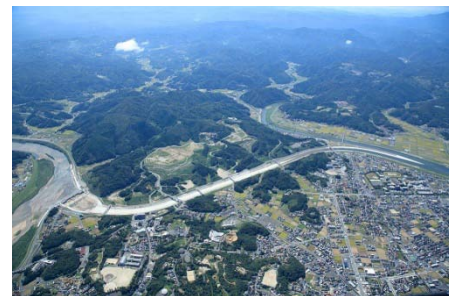
▲斐伊川放水路
