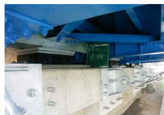
▲落橋防止装置の設置
