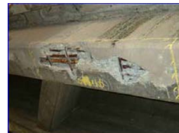
経年劣化及び中性化による主桁コンクリートの剥離及び鉄筋露出 (国道2号 山王橋)
