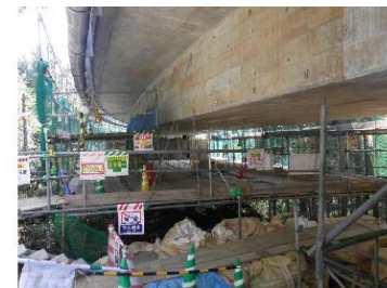
▲竣工後44年を経た国道53号那岐大橋(智頭町内)の主桁を対象とした補修工事
