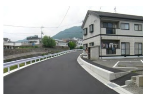
【地域と協力して整備した道路】
