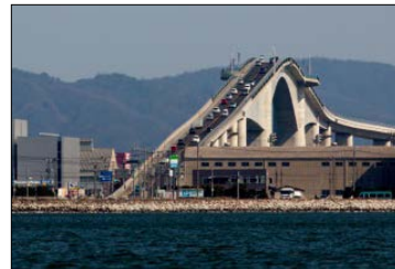
境港臨港道路江島幹線 江島大橋
