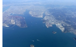
水島石油化学コンビナート 出典: 中国地方整備局
