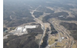
尾道松江線 吉舎 I C 付近 出典: 中国地方整備局
