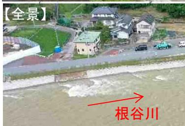
【護岸損傷】L=20m
