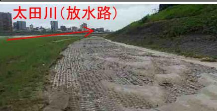
【護岸損傷】L=20m
