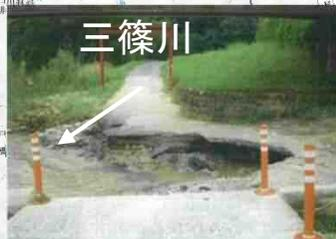
【護岸損傷】L=40m
