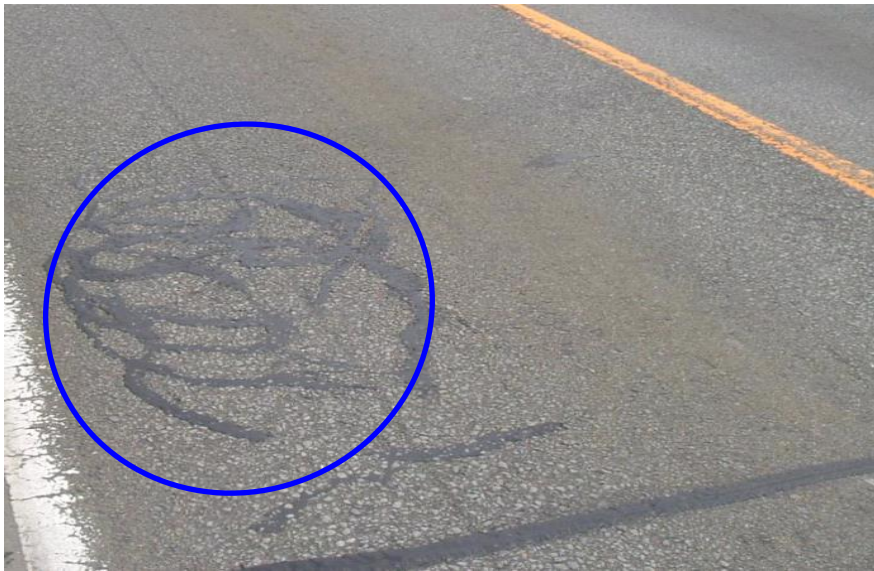
【路上の状態確認】
