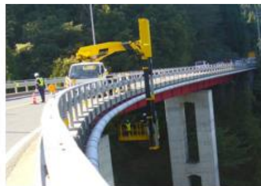
橋梁点検車による定期点検
