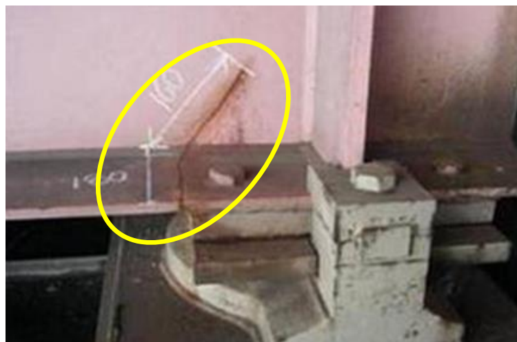
➤ 主桁の亀裂
