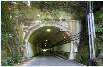
<仁方隧道の状況>
