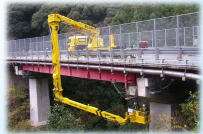
<橋梁点検車による点検>
