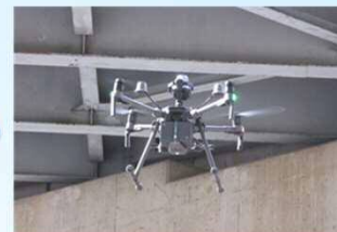
＜ドローンによる点検＞
