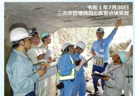
<直営点検の実習風景>
