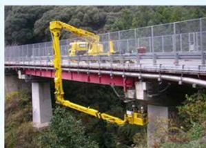
＜橋梁点検車による点検＞
