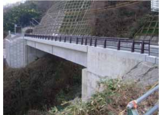
写真 2-1 小川尻橋架橋状況
