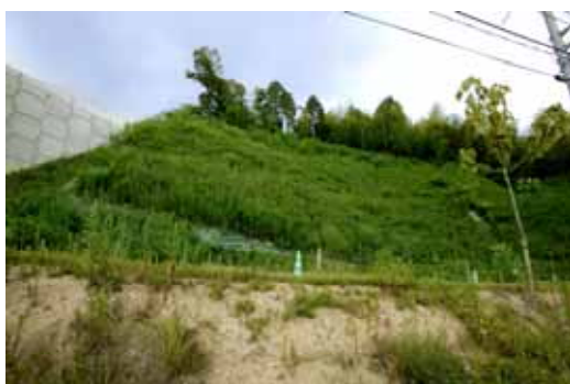
施工後3年経過。木本類の生育が確認できる
