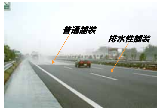
写真 4 排水性舗装の排水状況 (写真提供: 日本道路公団)
