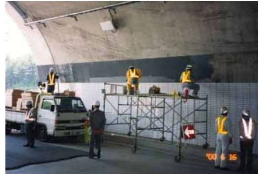
写真 3 リサイクル外装壁タイルのトンネル側壁施工状況
