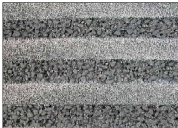
写真 1 抑制材の配置状況例
