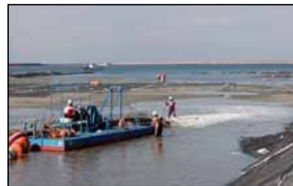
写真-6 水搬工法による覆砂
