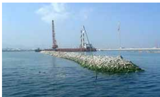
写真-2 中仕切り堤の造成
