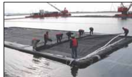
写真-5 シート敷設状況
