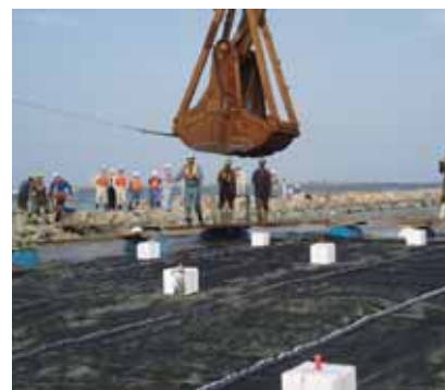
写真-4 試験施工状況
