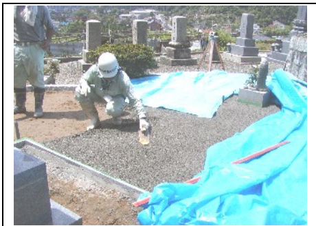
写真3. EBマルチング施工状況
