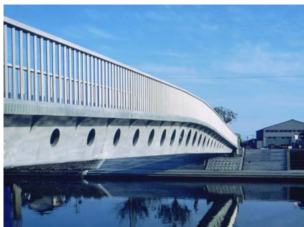
写真-1 酒田みらい橋（橋長 50m）
