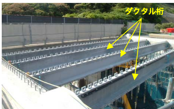
写真-9 東九州自動車道 堀越Cランプ橋
