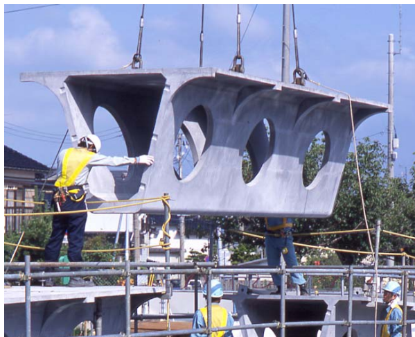
写真-7 酒田みらい橋 架設状況
