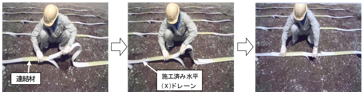
図-2 ネットワークドレーン工法の施工フロー
