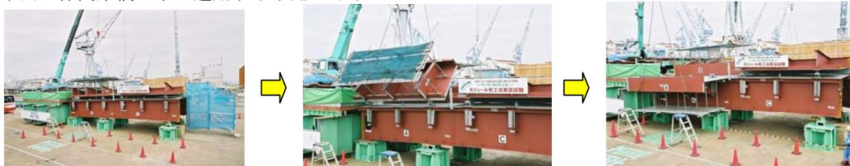
図-5 モジュール桁工法の検証試験
