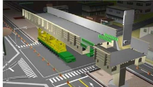
(4) 同じくリフトアップ装置にて高さ調整を行い、橋桁を接合する。
