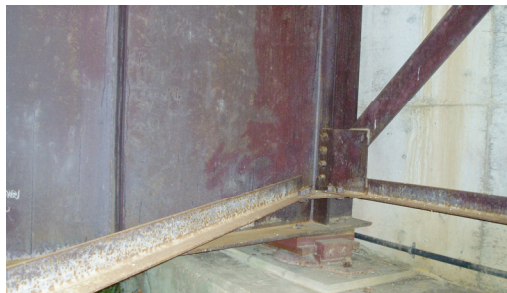
(a) 支点付近の内側ウェブ側
