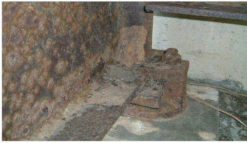
(a) 支点付近の内側ウェブと下フランジ上面
