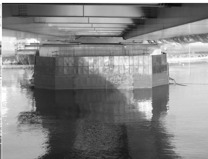
函体設置完了
