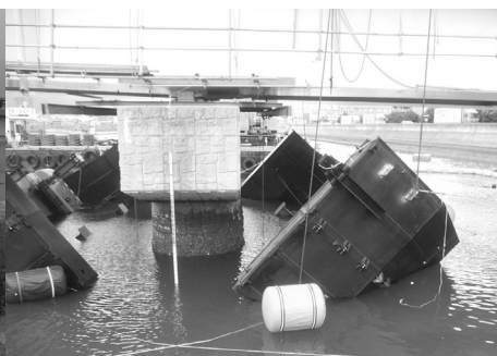
函体設置状況
