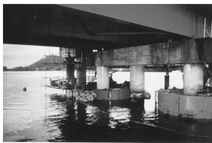
函体設置状況
