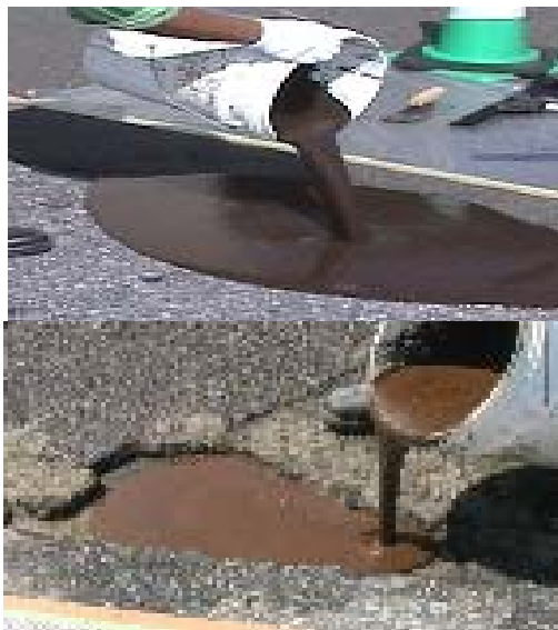
写真—2 混合物排出状況
