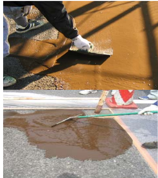
写真—3 敷きならし状況
