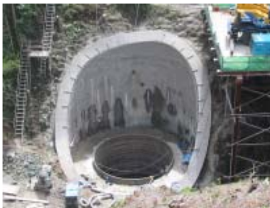
写真-1 竹割り型土留め工完成写真
