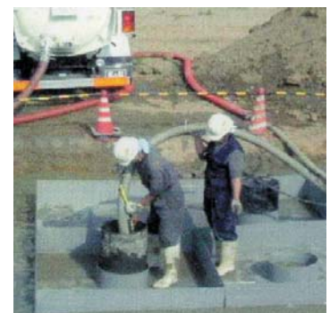
図-13 真空ポンプ工法
