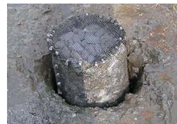
写真-1 浸透柱の設置状況
