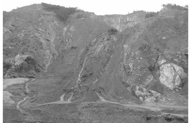
写真－1. 崩落直後の斜面状況
