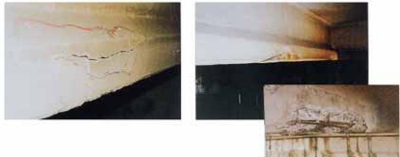
写真-1 塩害事例 (プレテンション方式 P C T 桁)
