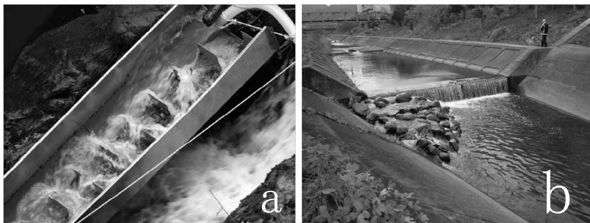
図2. 金属製V字断面小型魚道(a)および天然石組魚道(b).
