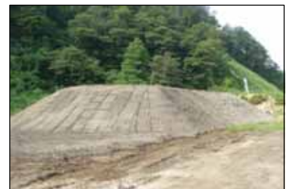
写真 - 5.1 未分解チップ堆積状況
