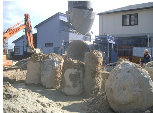
写真-13 宝塚市施工状況
