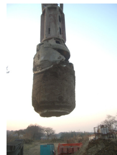
写真-10 切断杭体を引上げた状況
