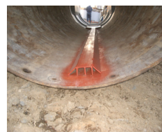
写真-5 油圧ホース保護カバー
