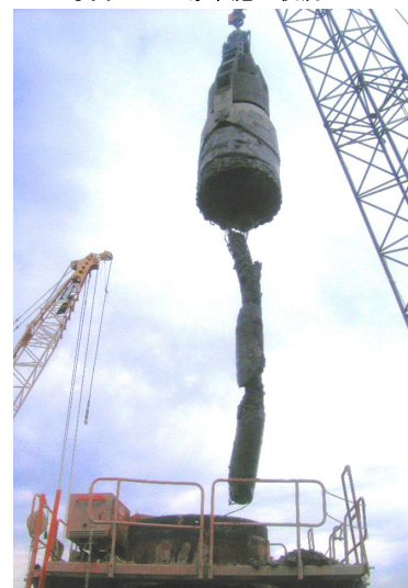
写真-14 川崎市施工状況
