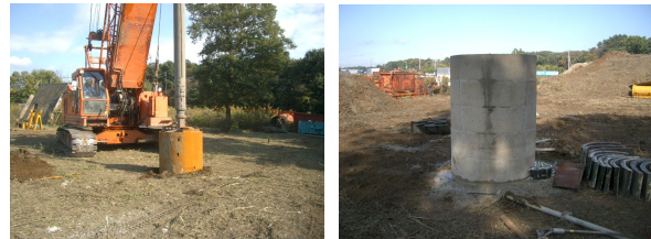
写真-9 杭築造状況とφ1100杭地上突出部
