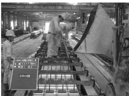
写真-3 コンクリート打設
