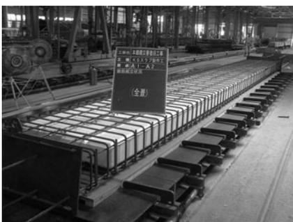
写真-1 鉄筋組立完了
