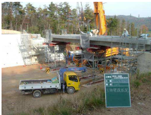
写真10 プレキャストセグメント工法 施工状況
