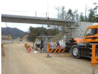
写真9 仮受けベントの解体
