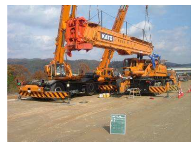
写真4 架設機組立据付
