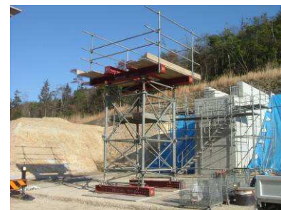
写真3 仮受けベントの設置
