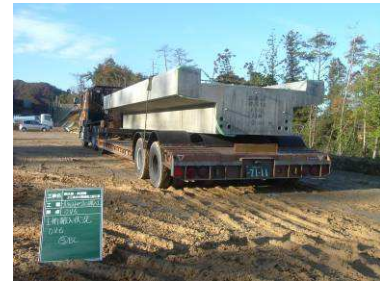
写真5 セグメント桁搬入
