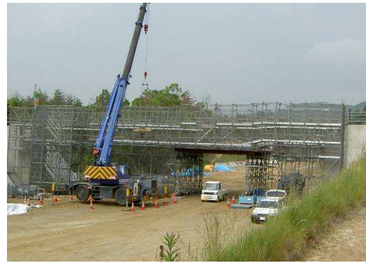
写真11 現場打ち 施工状況
