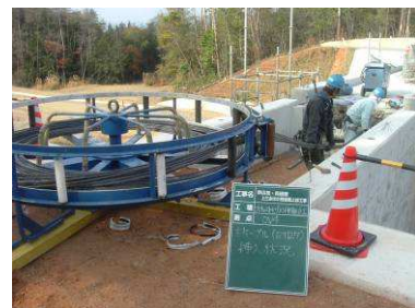
写真7 PC鋼材の挿入
