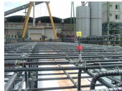
写真2 セグメント桁制作工
