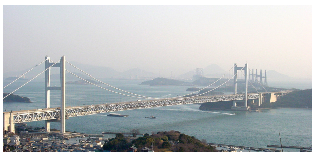
写真-4 浅い水深と多くの島々の存在が本四連絡橋の架橋を実現させた
