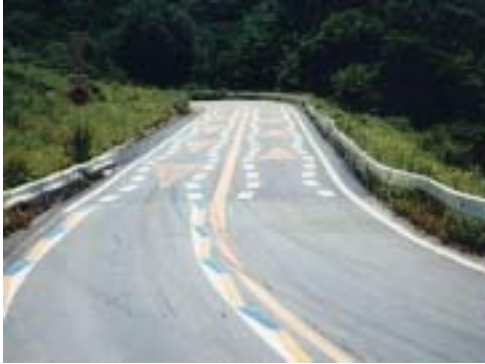
写真 - 5 路面標示
