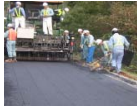
写真 - 2 敷き均し状況
