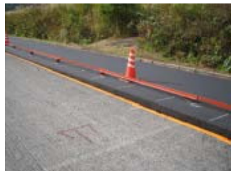
写真 - 4 片側車線施工後
