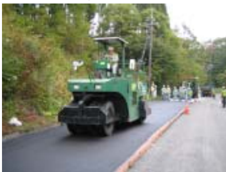
写真 - 3 転圧状況
