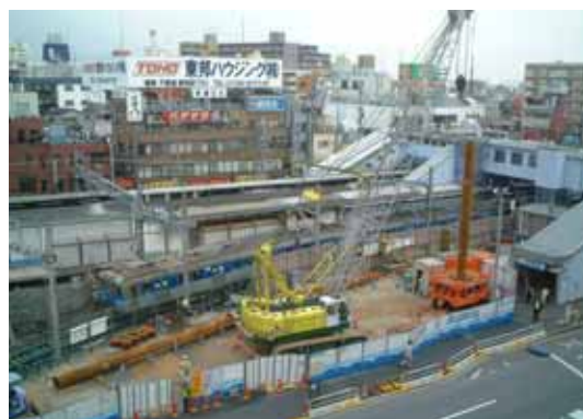
写真 - 4 狭隘地における施工状況
