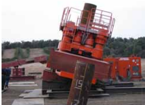
写真 - 3 斜杭の施工状況
