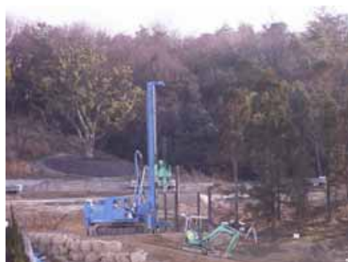
写真 - 5 回転杭現場状況
