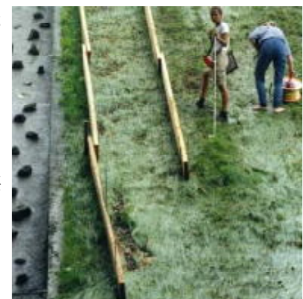
写真-5 耐流速性試験完了
