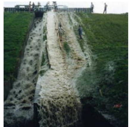
写真-4 耐流速性試験状況(貯水流下)
