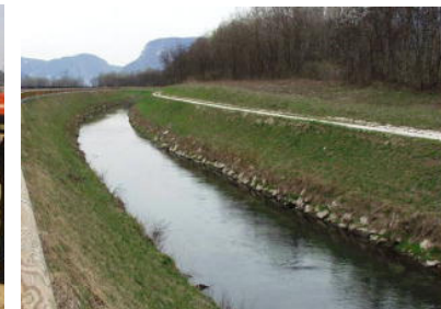
⑤植生工完了
