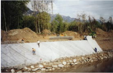
①3D protection パネル設置
