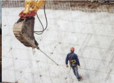
②アンカーバー設置
