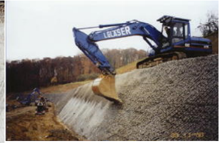
③バックホウによる碎石充填
