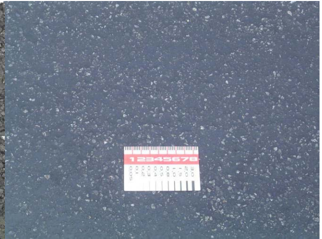
写真-3 車輪走行部の路面
