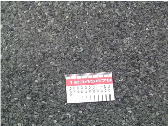
写真-2 非走行部分の路面
