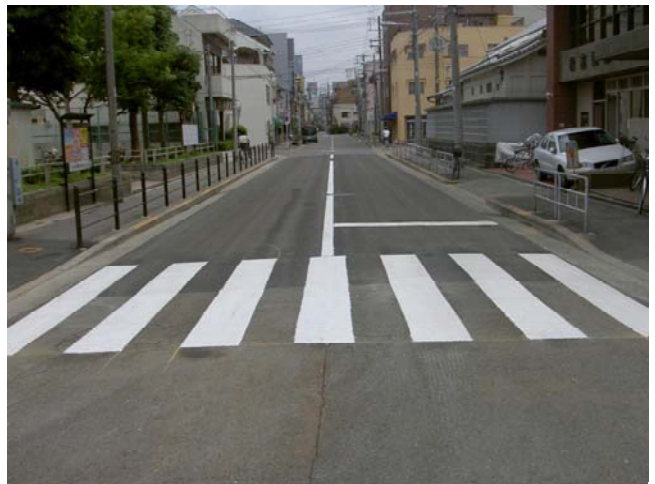
写真-5 市街地での施工例（大阪市）
